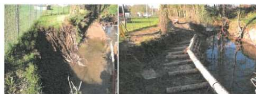
palificata semplice, prima e durante la realizzazione
